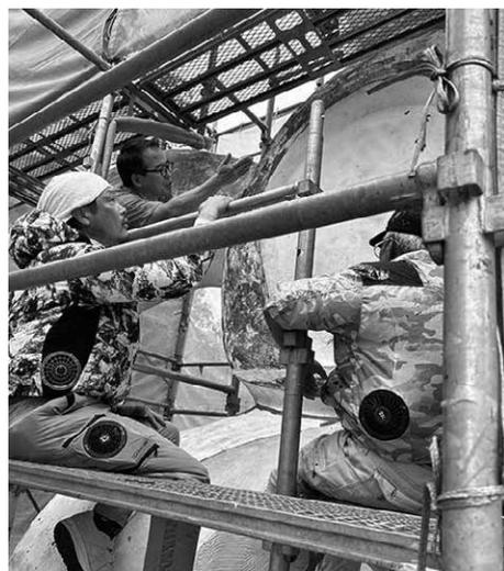
③9月15日。現場打合せ。塗装をはがし、下地を調整し、躯体内部の水抜きを行い、下地を再塗装。さらに色面を元通りに施すための輪郭確保用マスキングテープを貼り、下地のテクスチャー処理を打ち合わせて決めている。作業確認の最も重要な打合せである。
