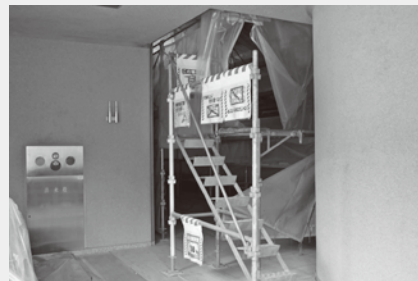
2階・常設展示室の状況(2020/12/11)
