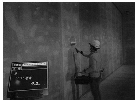
壁クロス工事：シーラー塗布状況
