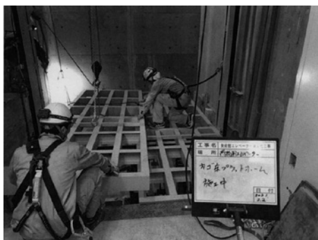
荷物用エレベーター：カゴプラットホーム組立
