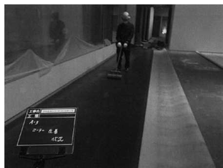
床：ローラー圧着状況
